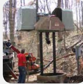
Al recibir los equipos, simplemente conecte las tuberías de succión y descarga así como la línea eléctrica, y asegure bien la estación al cárcamo. El proceso es típicamente completado en unas cuantas horas. Siempre está disponible la asistencia directa de S&L para el arranque de los equipos.
